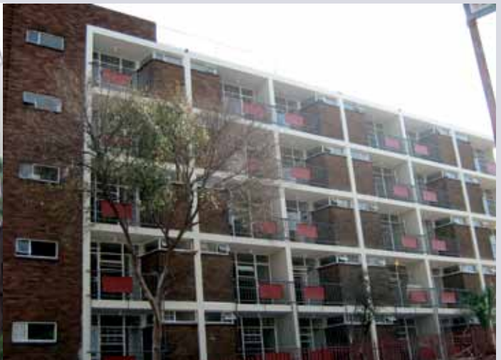
Als Towers after
